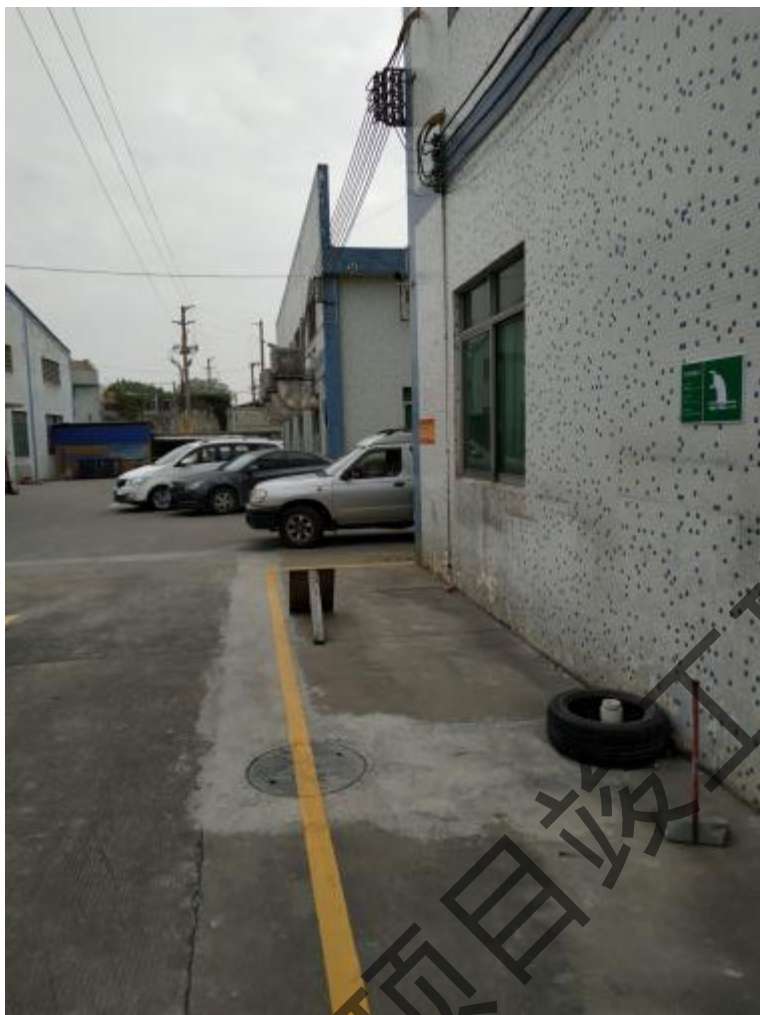
生活污水排放管道
