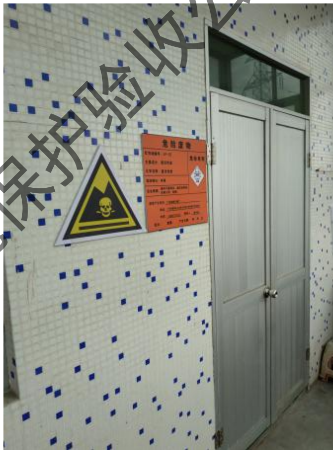
危险废物暂存场所 远照
