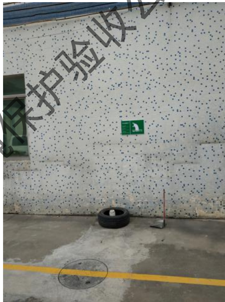
生活污水排放口 远照
