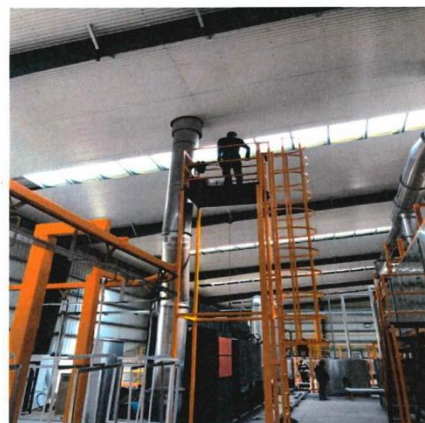
固化废气治理设施后排放口 4#
