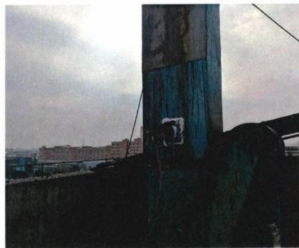
油烟治理设施后排放口 5#
