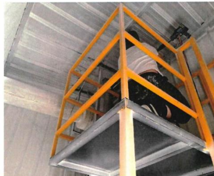
制粉线治理设施后排放口 2#
