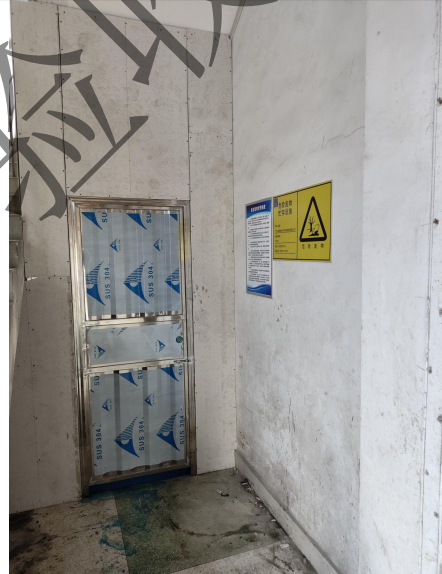
危险废物暂存场 TS001 远照
