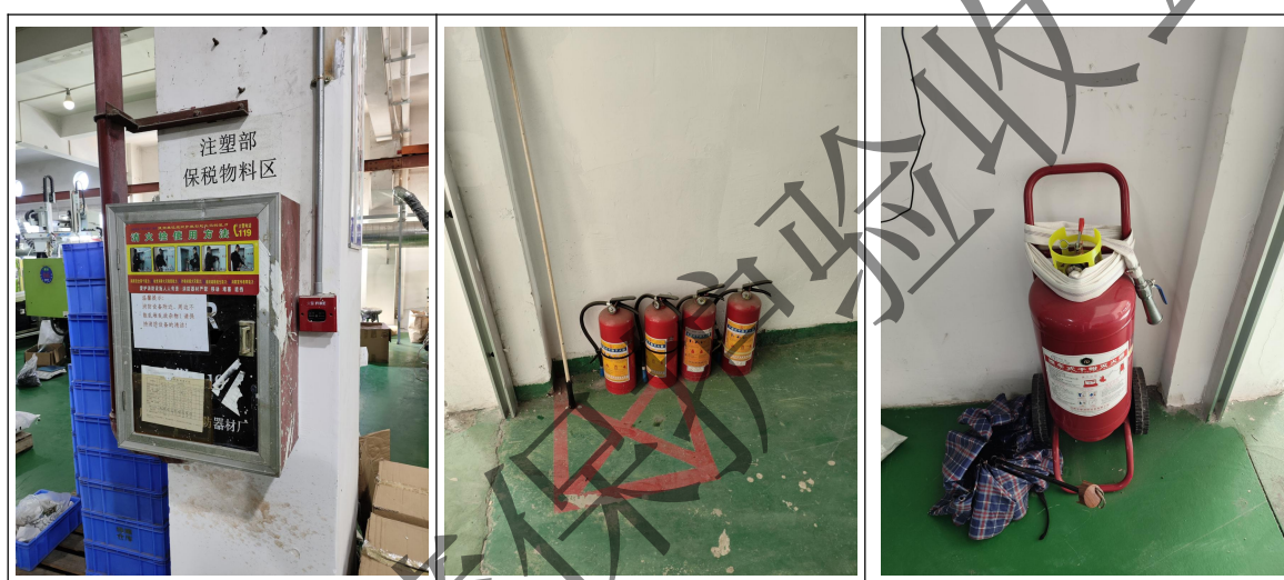
图 4.2-1 应急设施、物资现场照片
