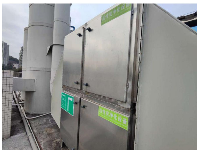
产业园废气治理设施TA001：碱液喷淋塔（设除雾装置） +一级活性炭吸附装置
