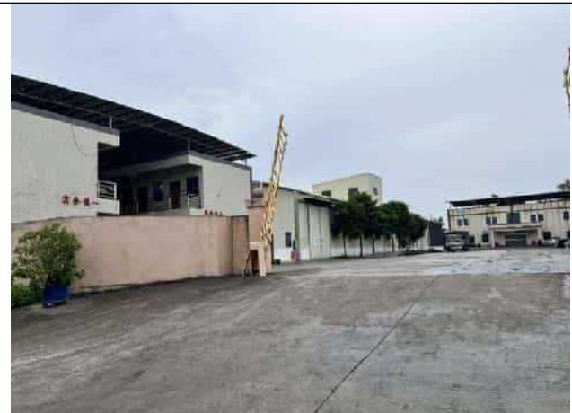
东北侧紧邻广东利羽蛋白饲料有限公司
