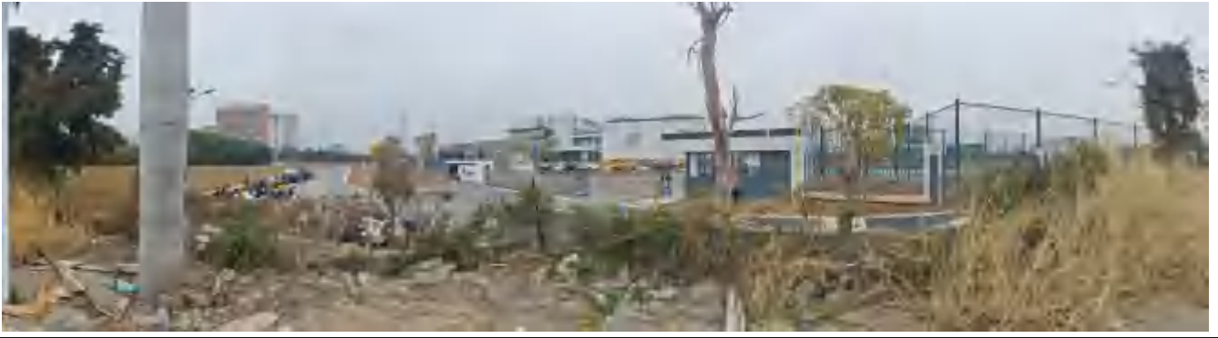
厂房东面桥南净水厂
