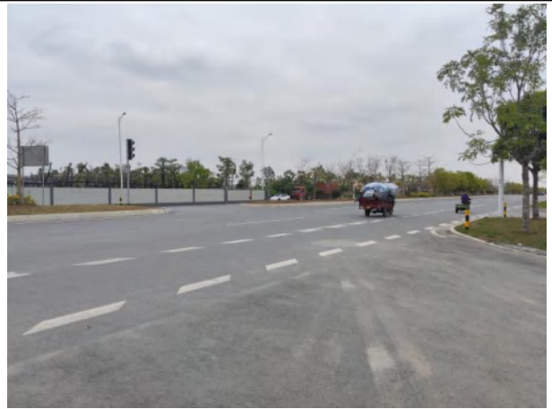
项目东北面-中船中路
