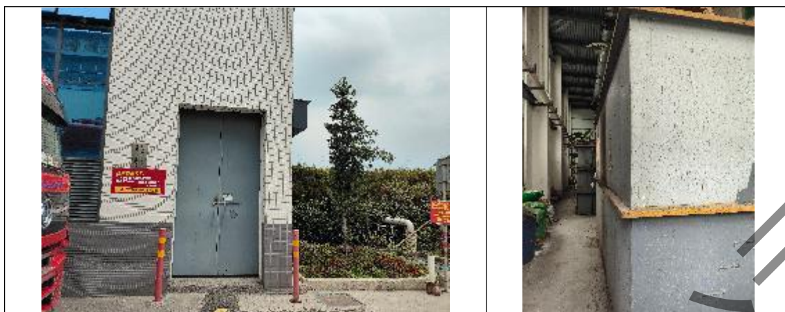
图 4.1-3 园区一体化处理设施现场照片
